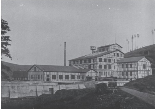
Bild 1: Aufnahme der neuen Aufbereitung Bergwerkswohlfahrt aus dem Jahr 1904
