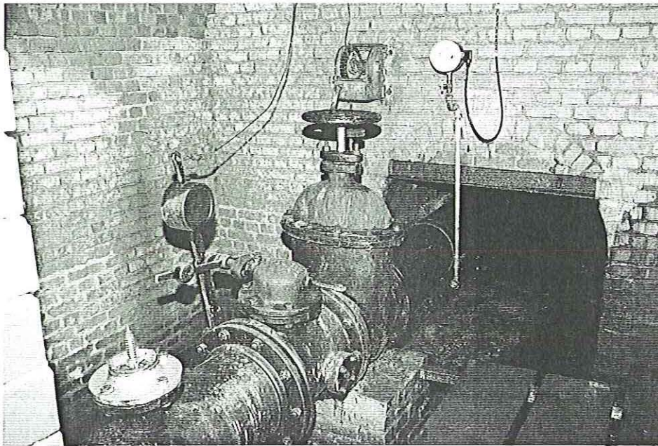
Abbildung 1: Die Schieberkammer am Hilfe-Gottes-Teich Foto: A. Rutsch
